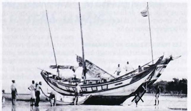
neux qui forme comme deux demi-carapaces séparées par une plate-forme totalement dégagée. Le récit d'Eric de Bisschop manque de détails techniques : pas de plans, pas de caractéristiques exactes, pas d'échantillonnages ni de détails d'emménagement intérieur. Le grément de jonque est volontairement bas et de surface réduite, la voilure que l'on peut estimer à 33 mètres
