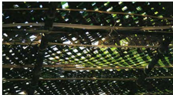
Ci-dessus : Habitation sur pilotis en Birmanie. Toiture en bardeaux de bambou, cloisons en panneaux de bambou tressé.
