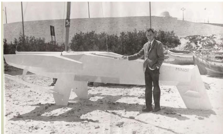
C'était un trimaran de 4,50 m de long, 4 m de large, pesant 125 kg environ. Il était réalisé entièrement en contreplaqué. Même le mât fut réalisé "sur mesures" : c'était une magnifique pièce de 7 m de haut, destinée à recevoir une voile de 17 m<sup>2</sup>... qui ne fut jamais montée, car je dus me contenter d'une voile de 12 m<sup>2</sup> récupérée sur mon vieux « As Côte d'azur ».
